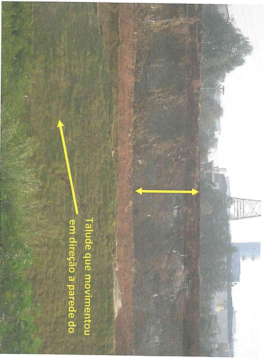
Trecho totalmente obstruído com o deslocamento da terra
